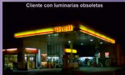
Cliente con luminarias obsoletas
