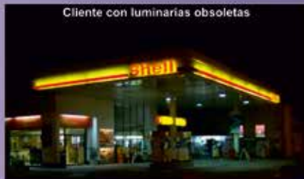
Cliente con luminarias obsoletas
