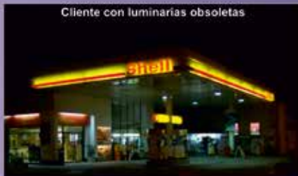
Cliente con luminarias obsoletas
